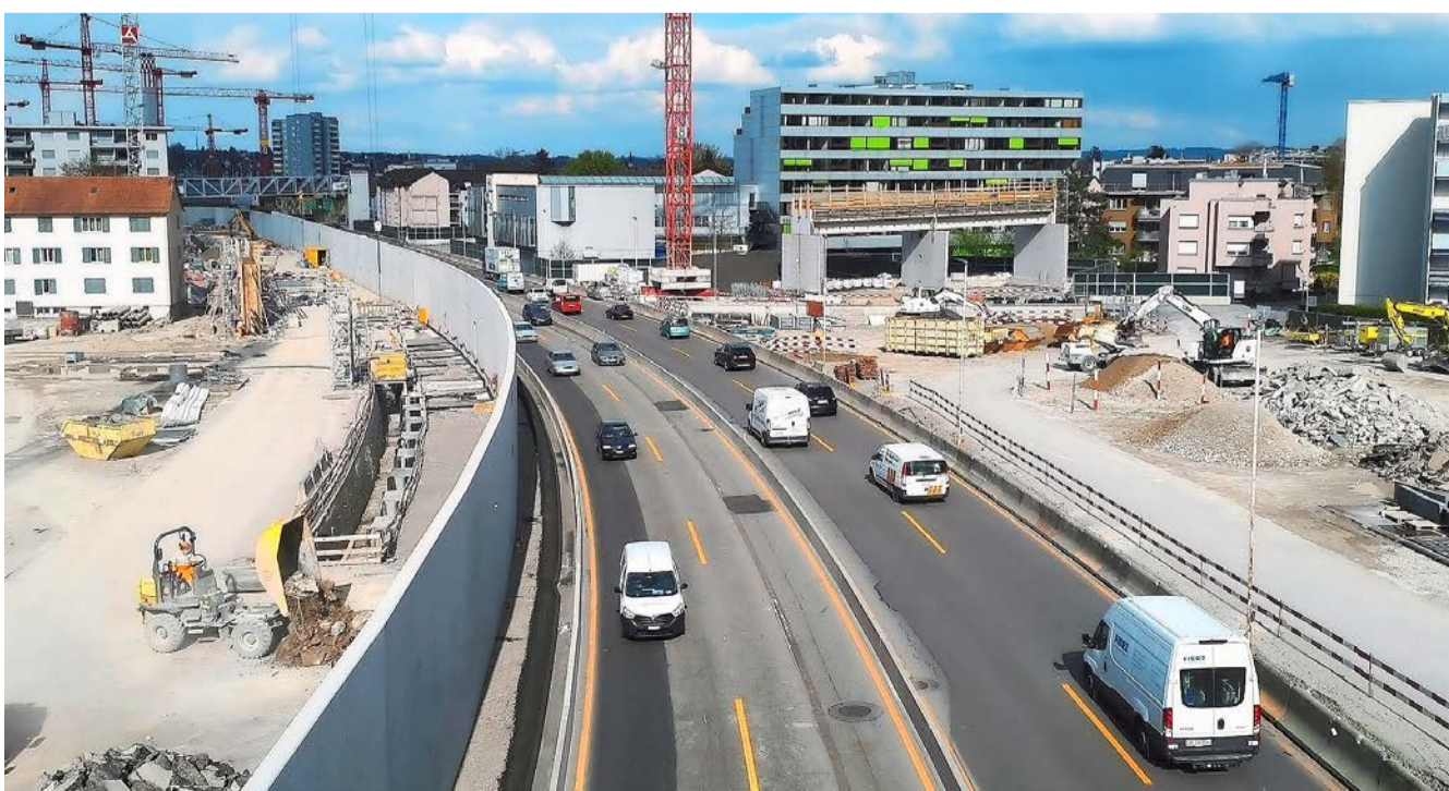
Blick auf die Autobahn in Richtung St. Gallen mit der Einhausungsbaustelle.
